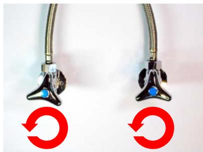
注) 水漏れが無いか確認してください。万一水漏れがある場合、止水栓を閉め最初からの手順を確認してください。
